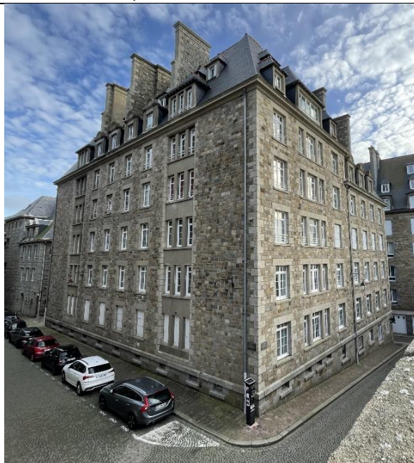
Figure 33 Immeuble collectif n° 1, depuis les remparts, Raymond Puthomme, 1947 © DJ 24/12/2023
