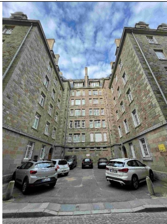
Figure 34 Immeuble collectif n° 1, depuis la rue d'Estrées, Raymond Puthomme, 1947 © DJ 24/12/2023
