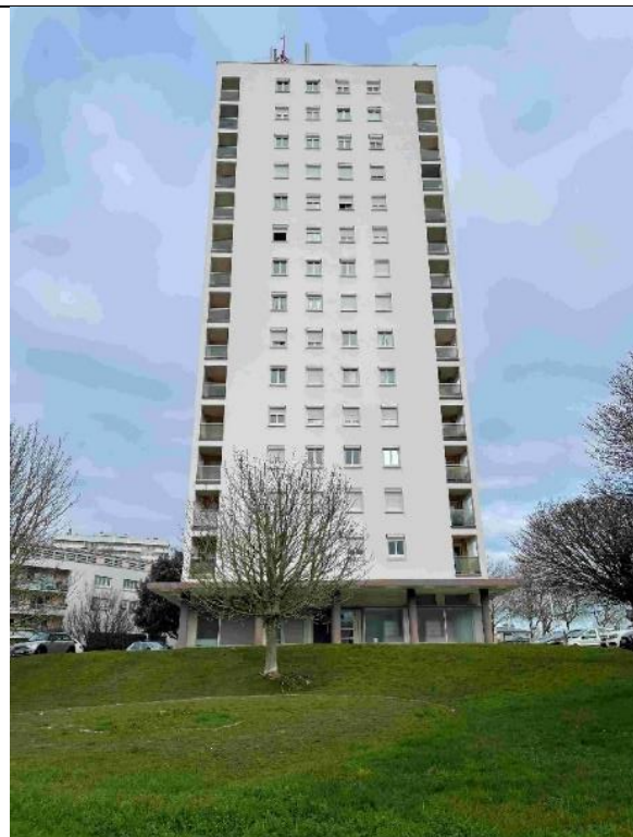
Vue de la tour Guémené depuis les espaces verts l'entourant avec la Banane en arrière-plan. La façade sud présente seulement des fenêtres et des loggias en angle. L'entrée de l'immeuble est surmontée d'un auvent en béton et entourée d'emplacement commerciaux.
