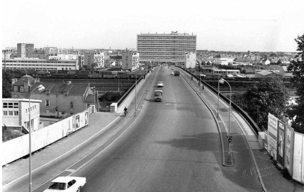
Vue du pont d'Oradour et du boulevard du même nom prise en direction de l'immeuble du Moustoir, conçu par Henri Conan (1917-1983) entre 1961 et 1963. L'importance de cet édifice dans le paysage urbain, marquant la nouvelle entrée du centre-ville, est particulièrement visible.
