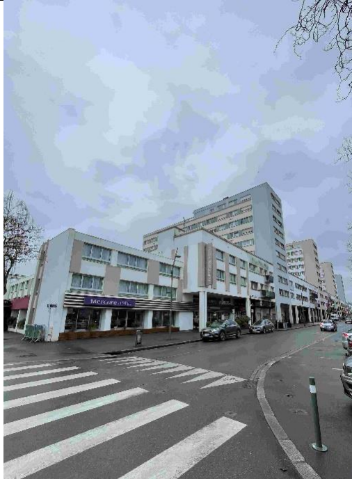
Figure 11 Immeuble, place Jules-Ferry, Lorient, Félix Le Saint (1913-1975), non daté © DJ 28/12/2023
