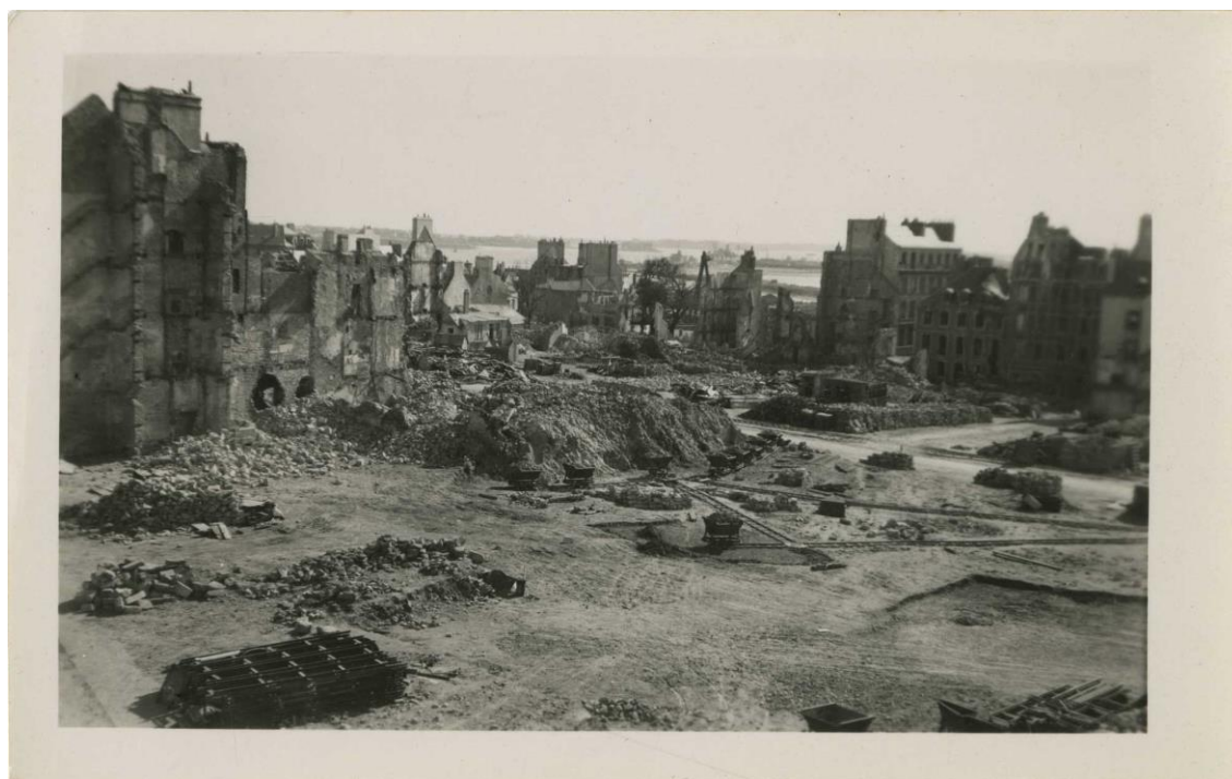
Vue prise de la place Bisson en direction de la rue du Port.
