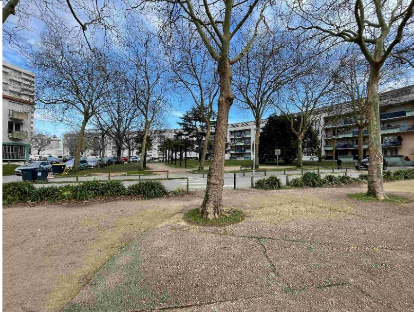
Figure 49 La Banane, vue depuis le square, Lorient, Jacques Bourgeois, Jean-Baptiste Hourlier, Paul Lindu, Georges Tourry, conçu en 1953 © DJ 11/01/2024
