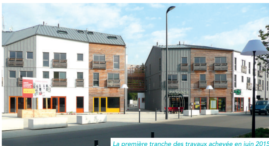
La première tranche des travaux achevée en juin 2015.
