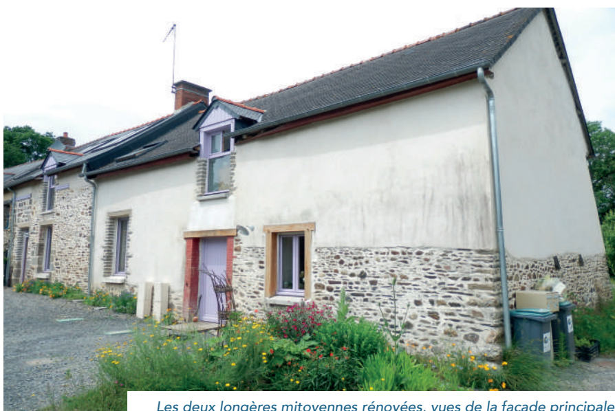
Les deux longères mitoyennes rénovées, vues de la façade principale.
