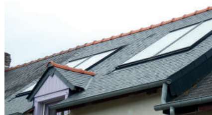
La nécessaire réfection de la toiture a permis d'inclure dans le projet l'intégration de panneaux solaires thermiques.
