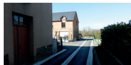
Les réseaux ont été dimensionnés pour urbaniser à terme les fonds de parcelles.
