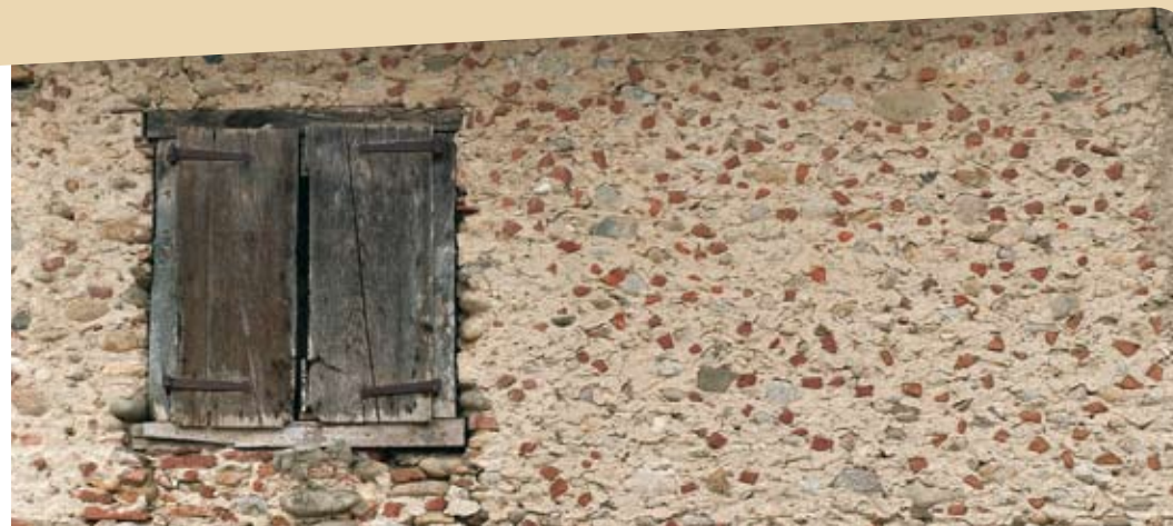
Construction en galet recouverte par un enduit à cassons de brique avec fenêtre en bois, Le Vernet - Ariège
