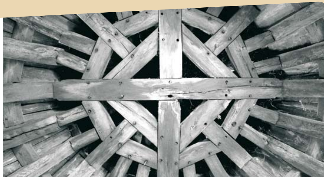
Charpente de l'Hôtel de Roaldès dit «Maison Henri IV», Cahors - Lot
